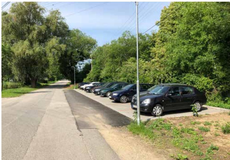
Vybudování parkovacích stání u firmy AGC Fenestra v Letošově
